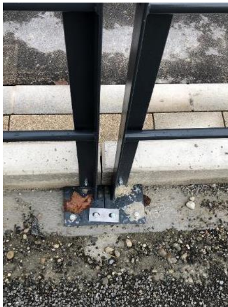
Obrázok 84_Příklad kotvenia zábradlia pod povrchom dlažby - detail
