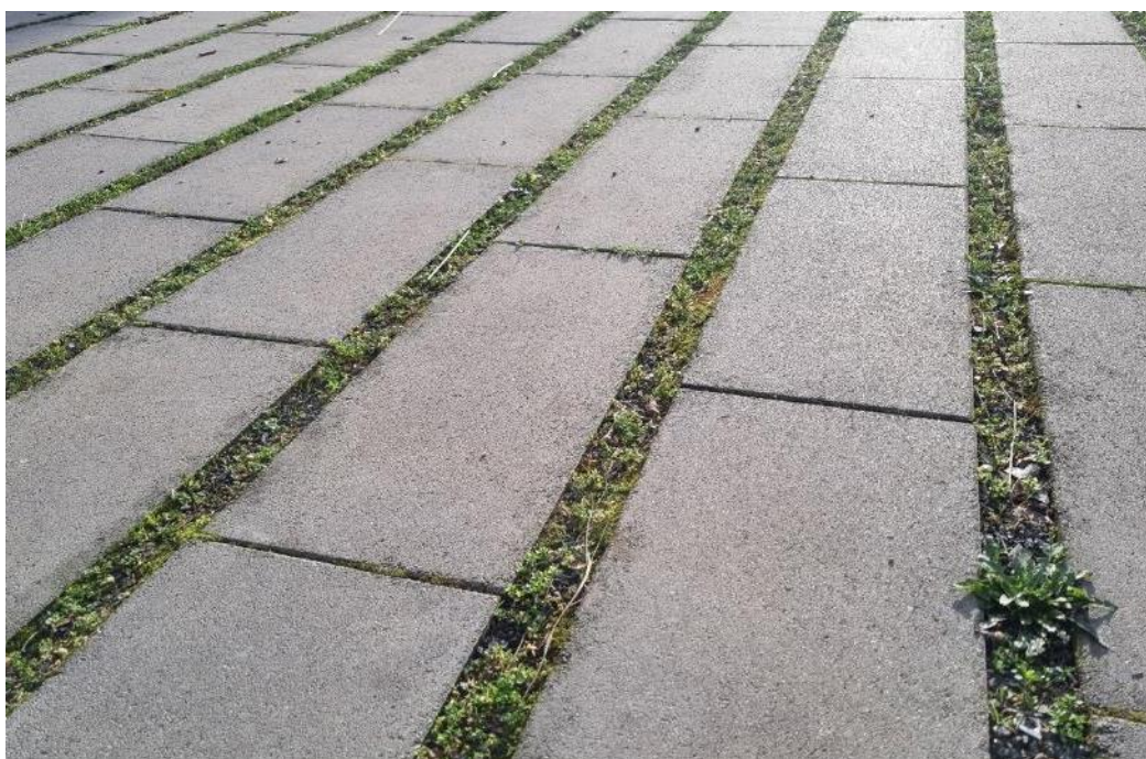
Obrázok 9_Príklad zatravnovacej dlažby
