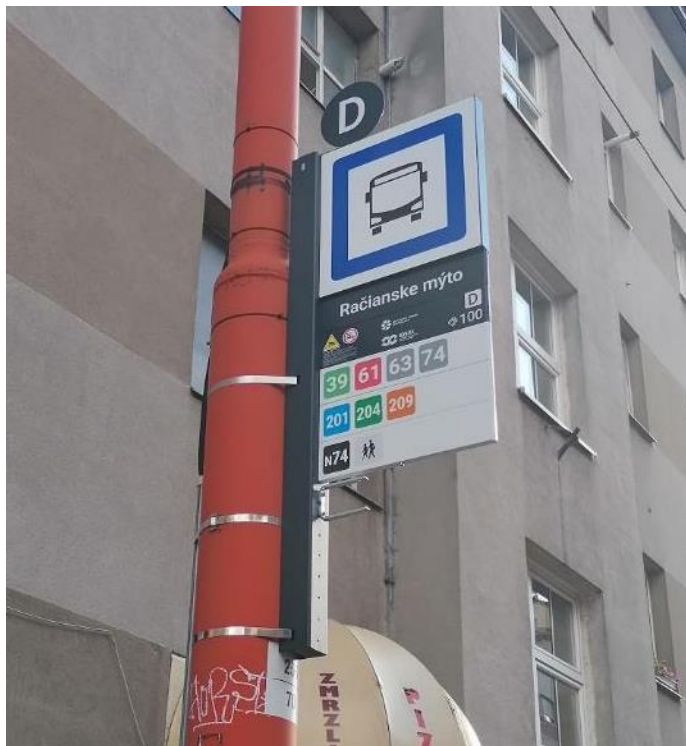
Obrázok 133_Príklad označníka na existujúcom stĺpe - farebnosť pásov nezodpovedá požadovanej farebnosti RAL 7016
