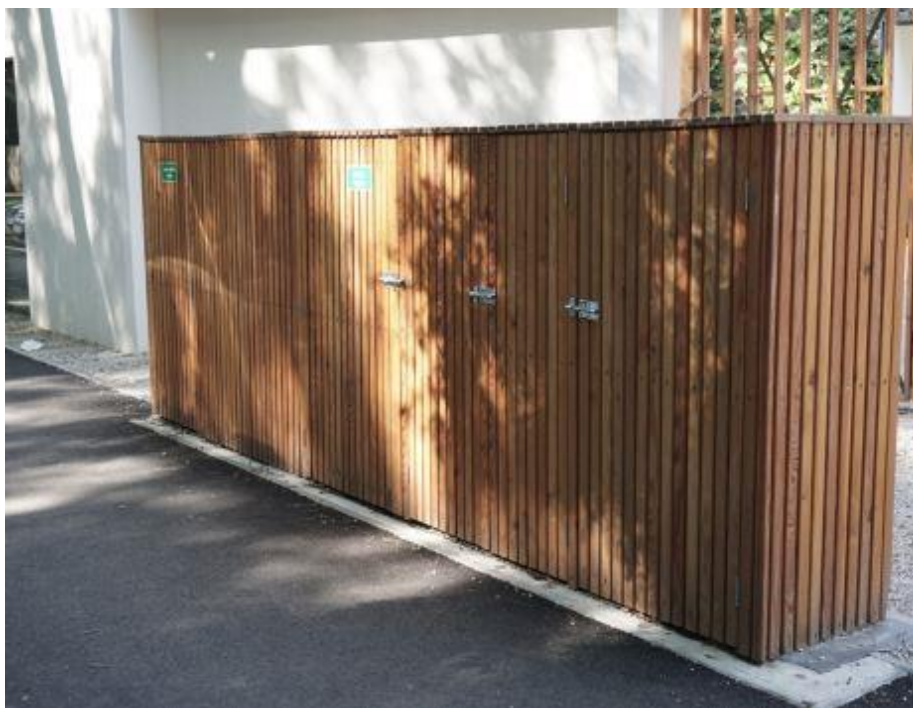
Obrázok 194_Príklad opláštenia z drevených hranolov
